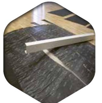
Parquet neuf gorgé d'humidité, bombé sur 10m<sup>2</sup>, à remplacer intégralement
